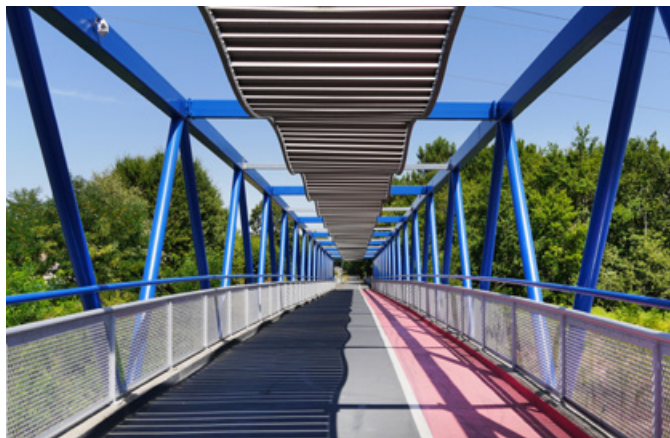
Passerelle sur router de Lacanau
